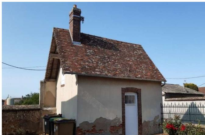
La municipalité a procédé à des travaux de réfection de toiture durant l'été. Le chantier a concerné le local des archives (pose d'un film sous toiture, changement des tuiles les plus abimées et des tuiles du faîte, pose de nouvelles gouttières, étanchéité de la cheminée) et le local de stockage (réparation de la charpente, pose de nouvelles tuiles) dans la cour de la mairie pour un montant de 13000 euros.
